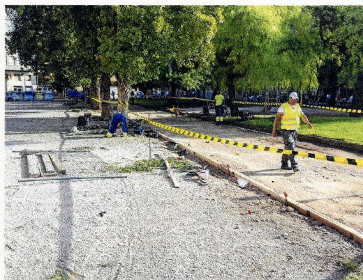
Obres a la plaça de les Corts Catalanes, al Temple. FOTO: JOAN REVILLAS
