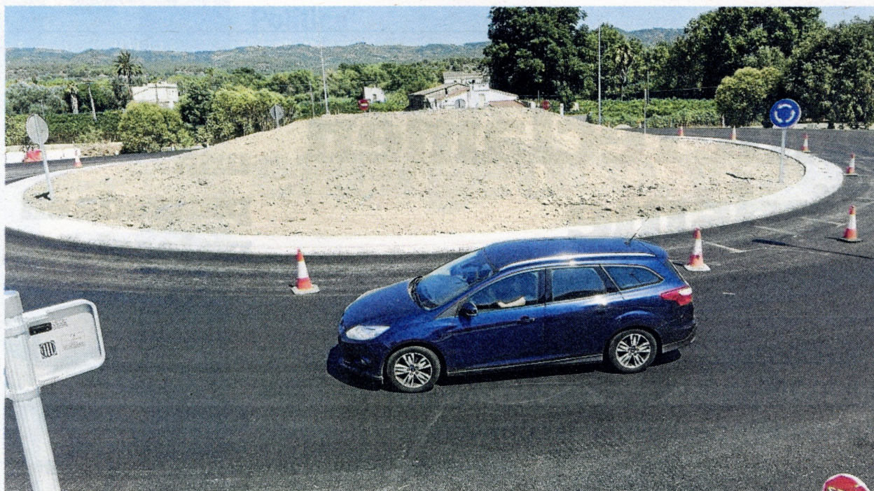
Aquests dies s'estan acabant les obres de la rotonda. FOTO:JOAN REVILLAS
