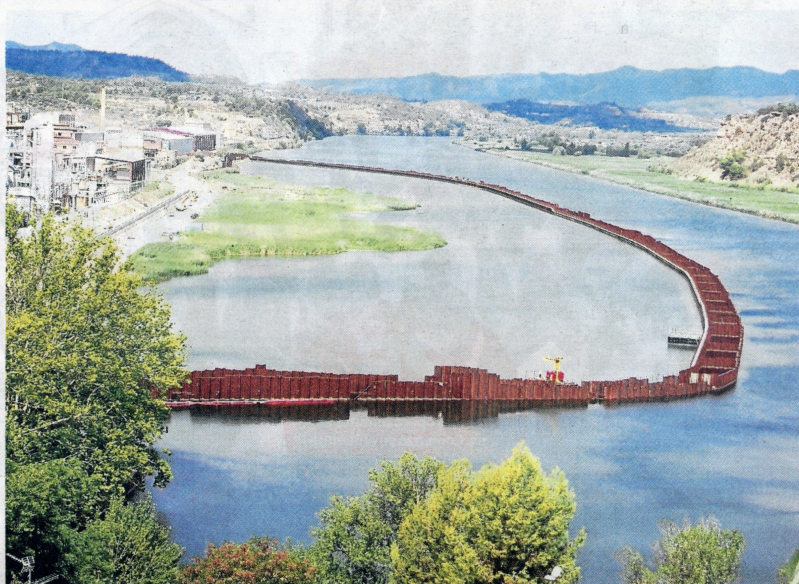
Labores de descontaminación química en el embalse de Flix (Ribera d'Ebre). FCC Construcción fue la adjudicataria del proyecto, uno de los ejemplos en los que el grupo compartió trabajos. FOTO: JOAN REVILLAS
