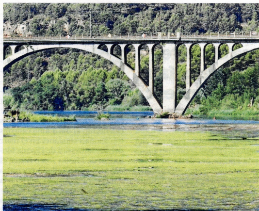
Acumulació de macròfits o plantes aquàtiques, al riu Ebre a l'altura del terme municipal de Garcia. FOTO: JOAN REVILLAS
