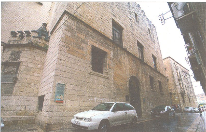
L'any 1963, es va aprovar traslladar-ne, pedra a pedra, la façana fins a la ubicació actual i convertir-la en la façana de la casa de la cultura./ L'EBRE
