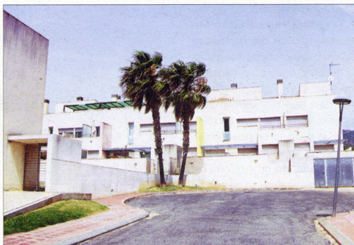
Imatge del bloc d'habitatges construït amb la llicència il·legal per la promotora Turov a Alcanar Platja, que han de ser enderrocats. / ACN
