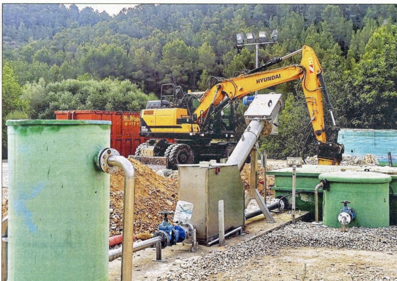
Imatge de les obres per a construir una nova depuradora a Tivenys, al mateix lloc on hi ha hagut durant 11 anys una depuradora inservible.
