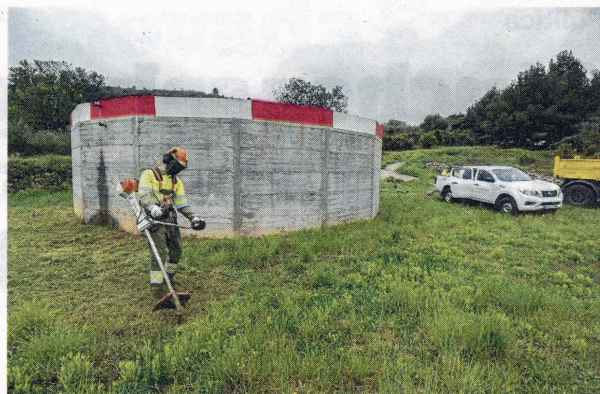
Treballs de manteniment d'un punt d'aigua per a incendis situat a Godall. FOTO: JOAN REVILLAS
