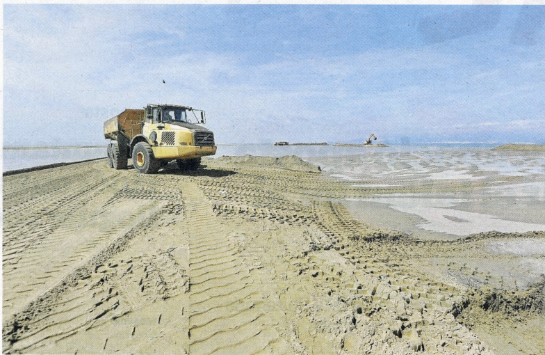
Treballs de reposició d'arenas a la barra del Trabucador. FOTO: JOAN REVILLAS
