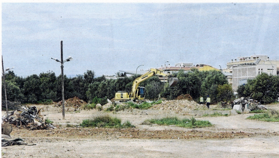
Treballs de gestió de la runa, als terrenys de la plaça de bous. FOTO: JOAN REVILLAS
