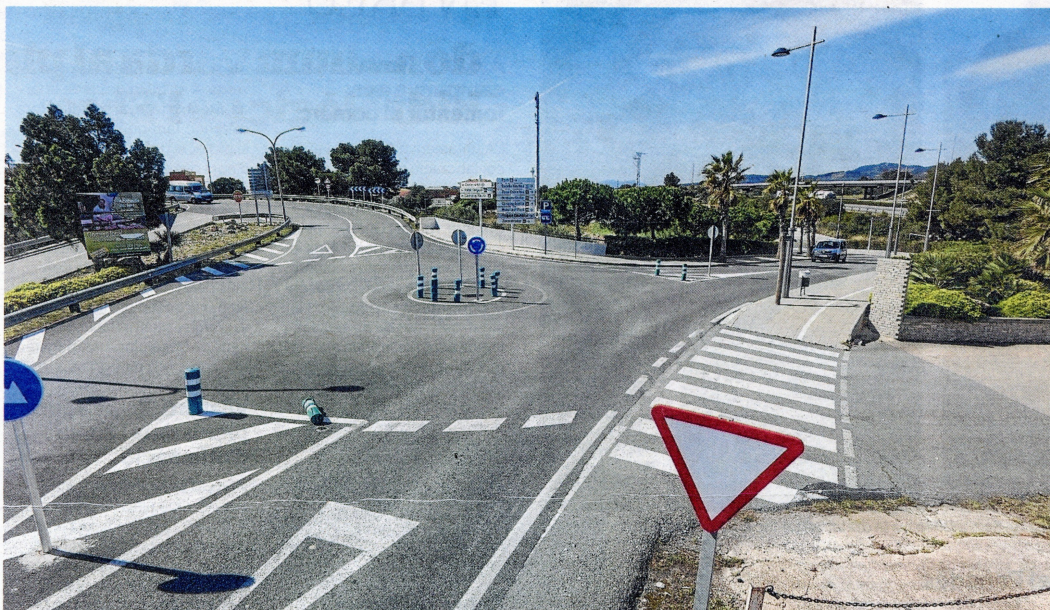
Espai on es construirà la nova rotonda d'accés al municipi. FOTO: JOAN REVILLAS
