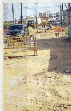
Obres al carrer Guifré el Pilós. FOTO: JOAN REVILLAS
