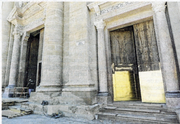
Les portes del temple s'estan revestint amb llautó daurat.
