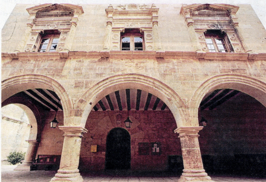
L'emblematíc ajuntament d'Arnes, edifici destacat del Renaixement català. FOTO: JOAN REVILLAS
