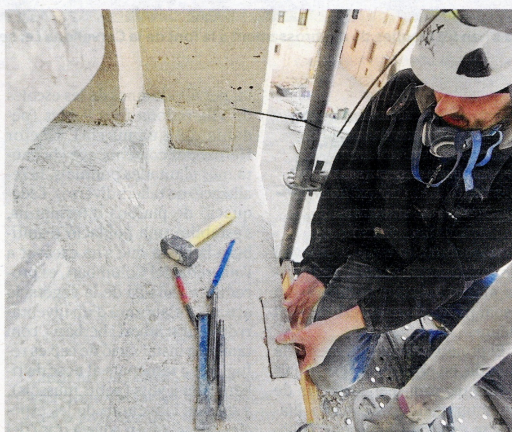
Els treballs es fan en altura dalt d'una gran bastida. FOTO: JOAN REVILLAS
