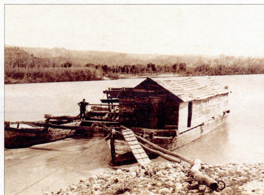
Imatge d'un molí flotant, construït sobre unes embarcacions que aprofitaven el corrent del riu per a fer moure les rodes, d'Aldover. / CEDIDA
