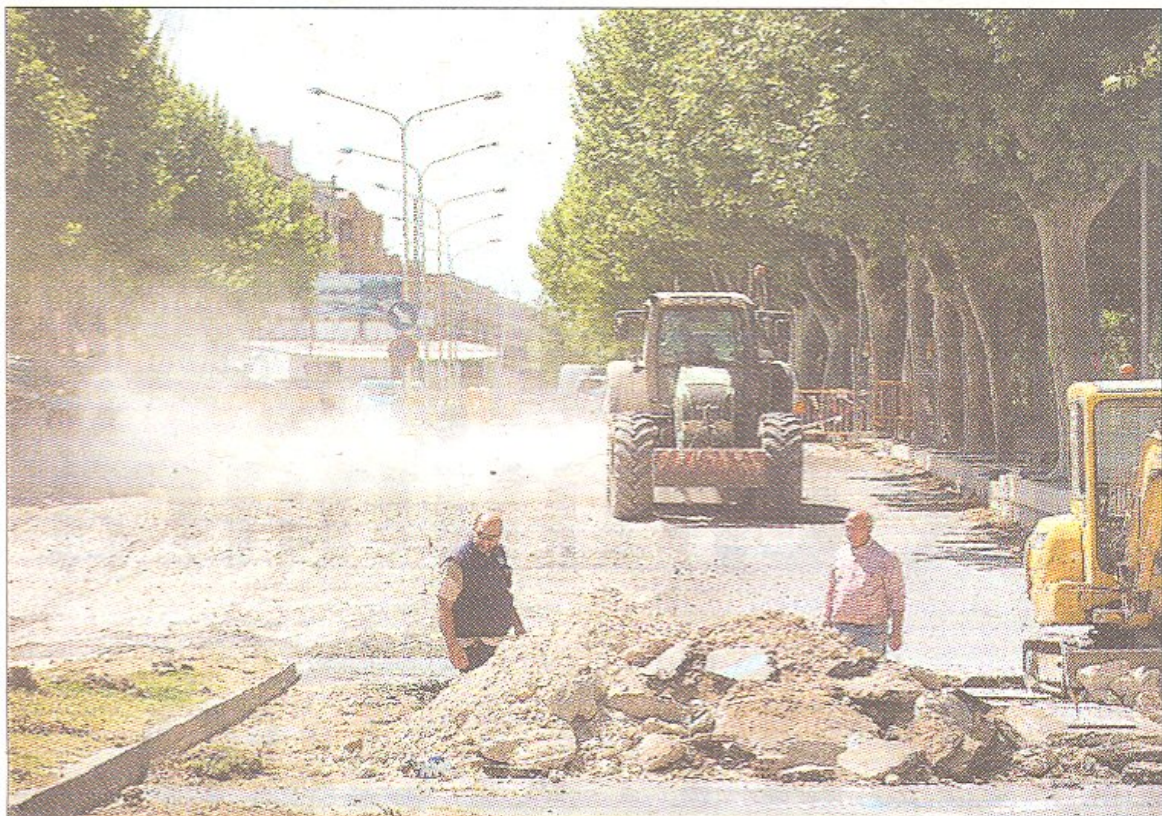
Imatge de l'inici de les obres de recreixement, ahir al matí, que formen part del projecte de prolongació de la Via Verda. FOTO: J. REVILLAS
