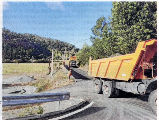
Detalls dels treballs al camí. FOTO: IDECE
