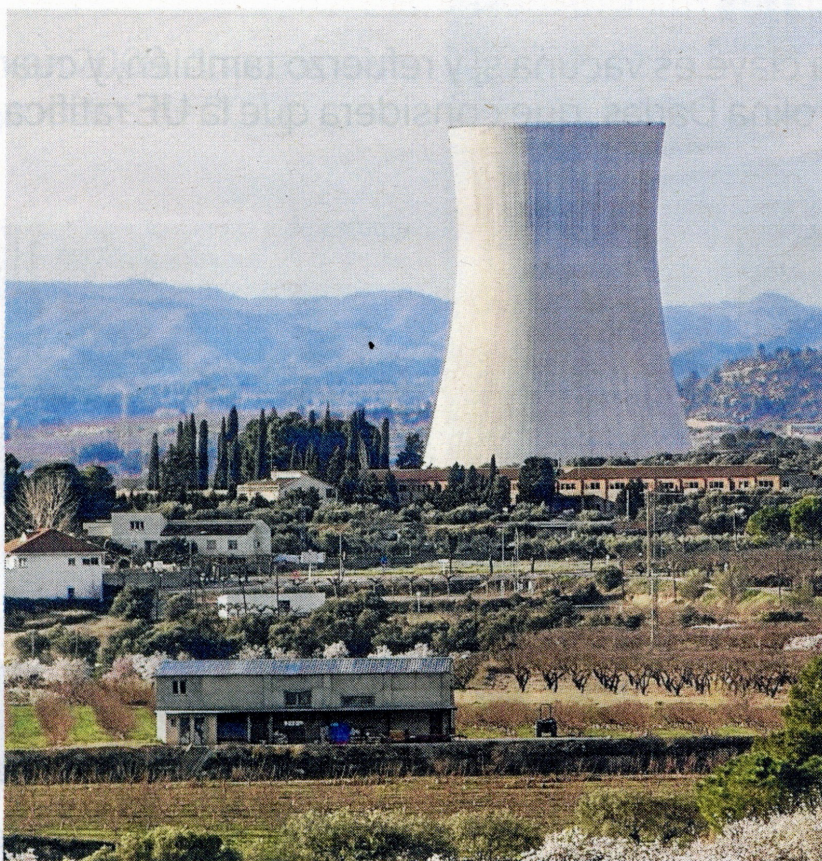
L'accident laboral mortal va passar a dins la central. FOTO: JOAN REVILLAS
