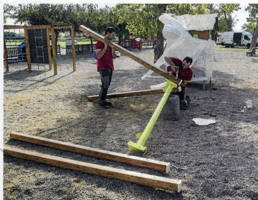
Instal·lant els nous jocs, ahir al matí. FOTO: JOAN REVILLAS
