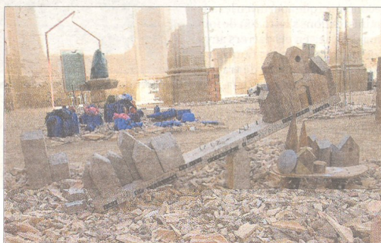
Dues de les obres de la Biennal, dedicada a l'habitatge digne. FOTO: J. REVILLAS
