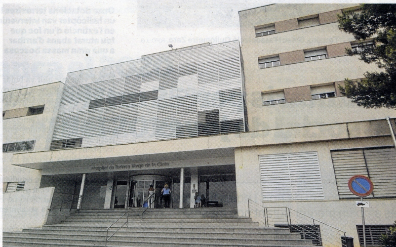
Imatge de l'actual Hospital Verge de la Cinta de Tortosa. FOTO: JOAN REVILLAS
