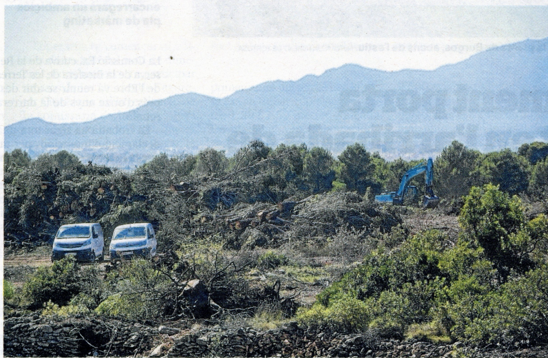
Treballs previs de desbrossament i moviments de terres, en marxa al polígon Catalunya Sud. FOTO: J. REVILLAS
