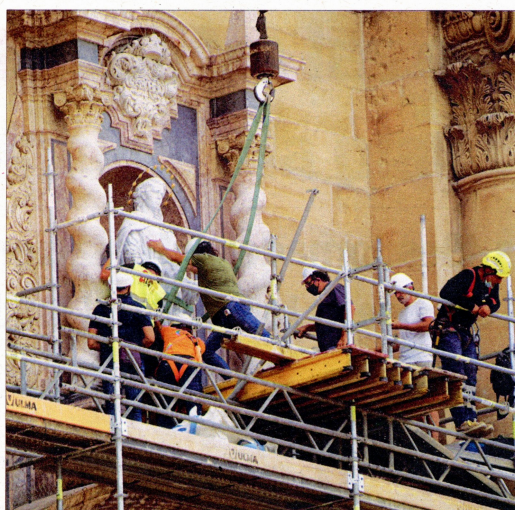
Detall de la instal·lació de l'escultura, a la façana central. FOTO NÚRIA CARO
