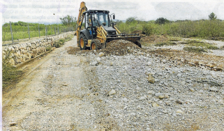
Una màquina retirant pedres del camí dels Valentins, ahir. FOTO: JOAN REVILLAS
