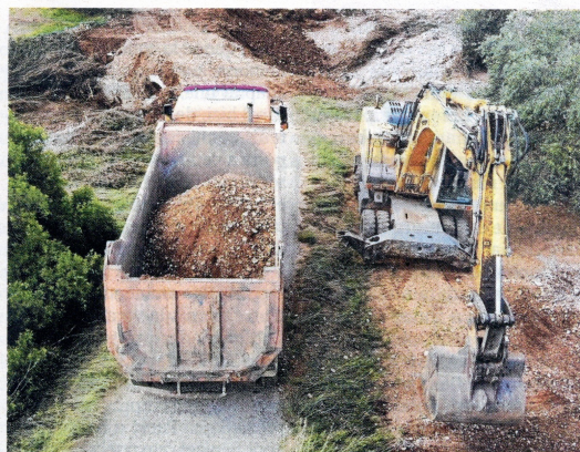
Treballs de reparació provisional de camins, en marxa. FOTO: CEDIDA
