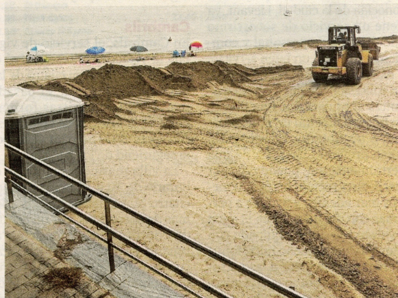
Trabajos de mantenimiento en la playa Cap Roig, en L'Ampolla, esta semana. FOTO: JOAN REVILLAS
