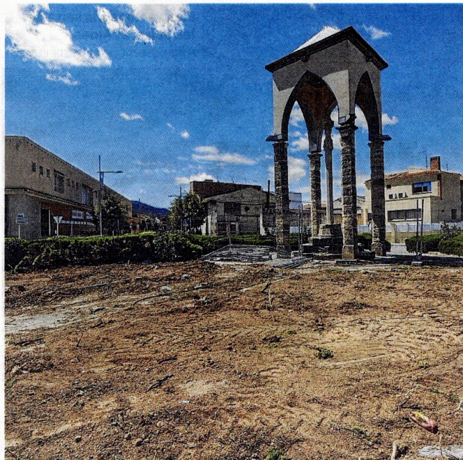
Detall de totes les plantes arrencades a la rotonda de la Creu Coberta, ahir a Gandesa. FOTO: JOAN REVILLAS
