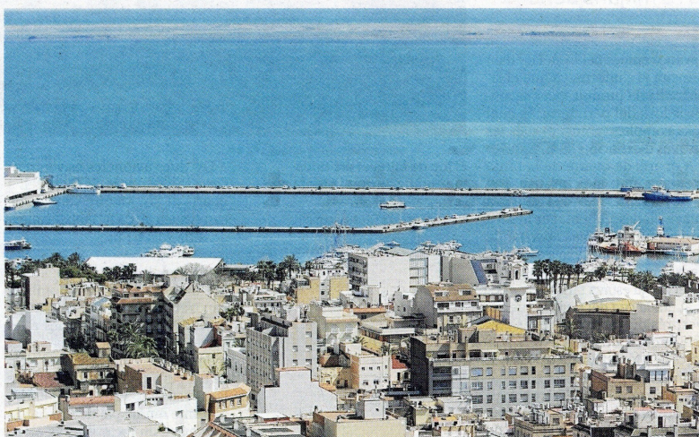
Detall del port de la Ràpita, on el nou edifici es construirà darrere de la Ilotja. FOTO: JOAN REVILLAS
