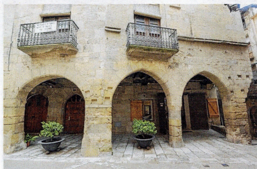
Pòrtics amb encaixos per sustentar elements de l'antic mercat. FOTO: JOAN REVILLAS
