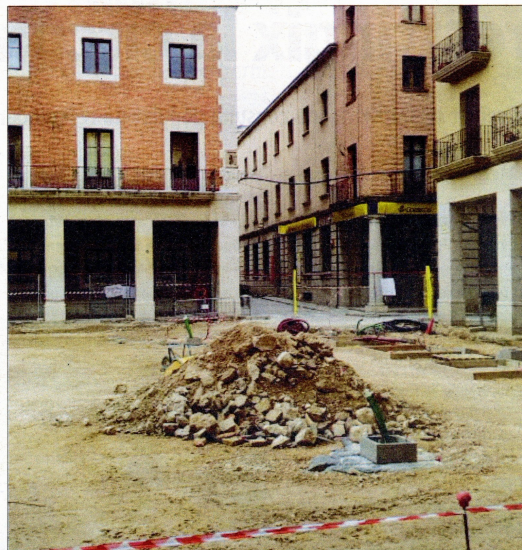
Aprofitant les obres de la plaça s'ha enderrocat el temple que coronava l'edifici de Correus que estava a punt de caure sol.
