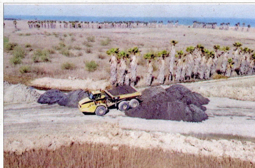
Imatges de la berma que s'està aixecant a Bombita per part de l'Estat i que ha pogut registrar Canal terres de l'Ebre.
