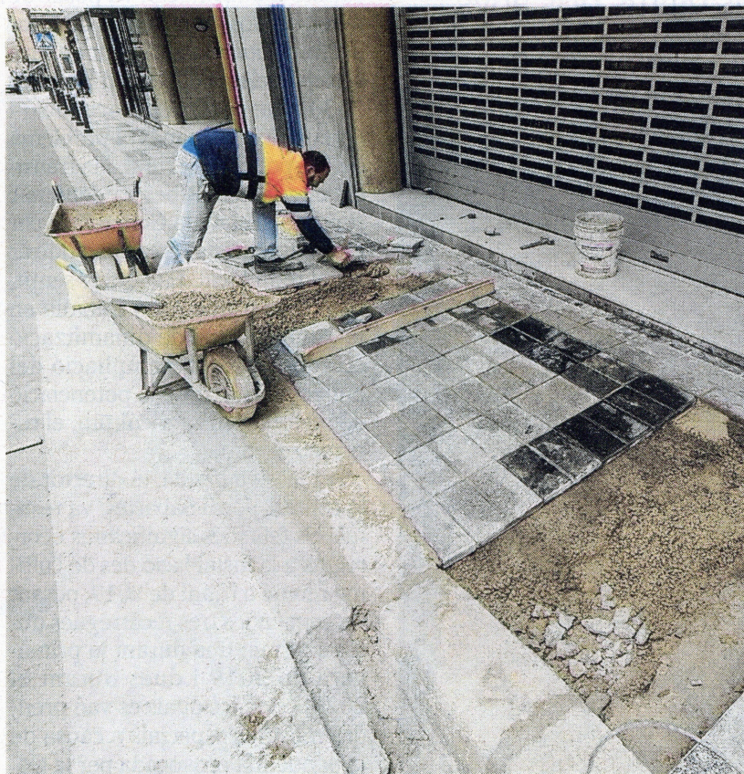
Un operari treballant al carrer Teodor González. FOTO: JOAN REVILLAS
