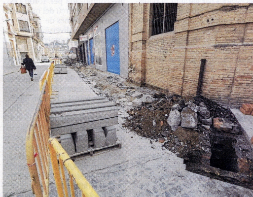
Adequació de les voreres al carrer Alfara de Carles. FOTO: JOAN REVILLAS
