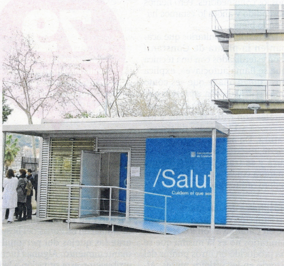
El módulo instalado junto al CAP Sant Rafael de Barcelona. ACN
