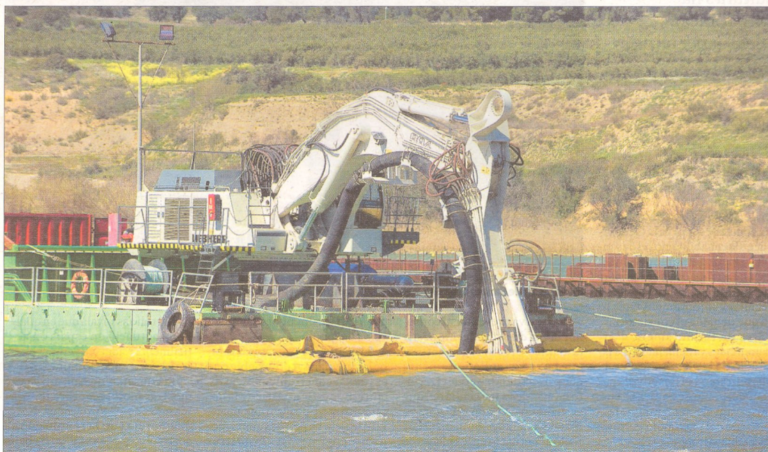
Imatge de la draga col·locada a l'interior del recinte aïllat de la bossa tòxica extraient els residus abocats al fons del pantà, ahir al migdia. FOTO: J. REVILLAS
