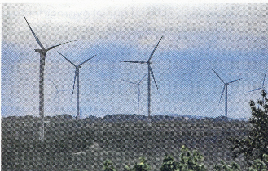
Aerogeneradors en funcionament a la comarca de la Terra Alta.
