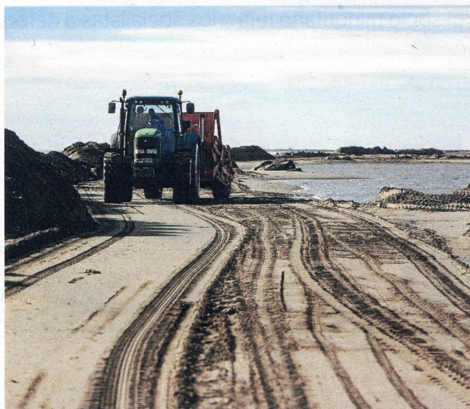
Treballs de transport de la sorra per refer la barra del Trabucador, malmesa pels temporals. FOTO: JOAN REVILLAS
