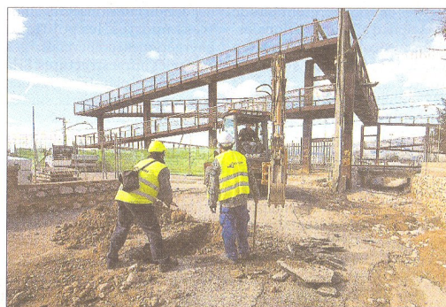
Imatge de l'inici dels treballs de millora de la capacitat de desguàs del barranc de la Llet, ahir al matí. FOTO: JOAN REVILLAS
