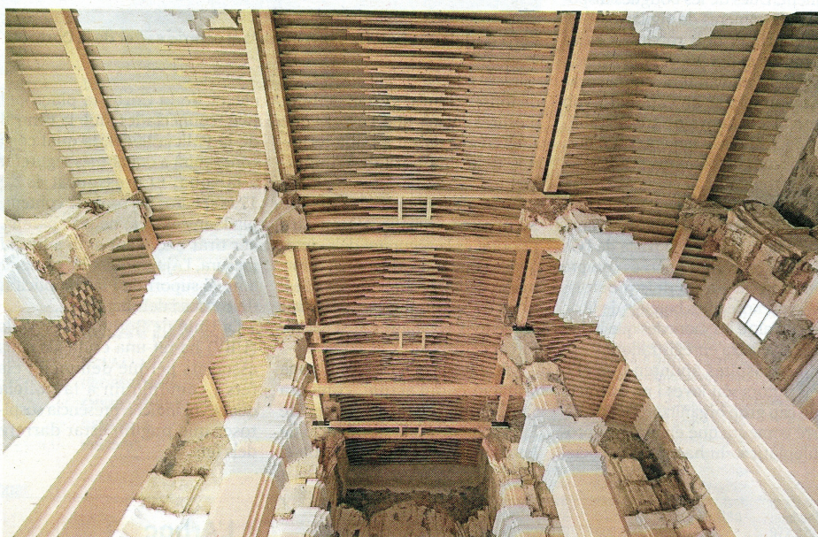
L'interior de les naus, amb la nova estructura de fusta de sustentació de la coberta. FOTO: JOAN REVILLAS
