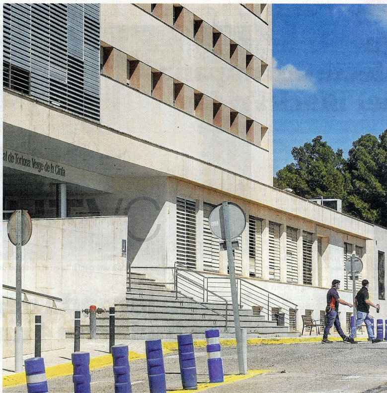
Entrada principal al Hospital Verge de la Cinta, el de referencia en las Terres de l'Ebre.
