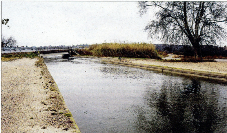
Les obres de l'encreuament del barranc de Sant Antoni amb el Canal de la Dreta han estat llargament reivindicades pels regants. / N.CARO
