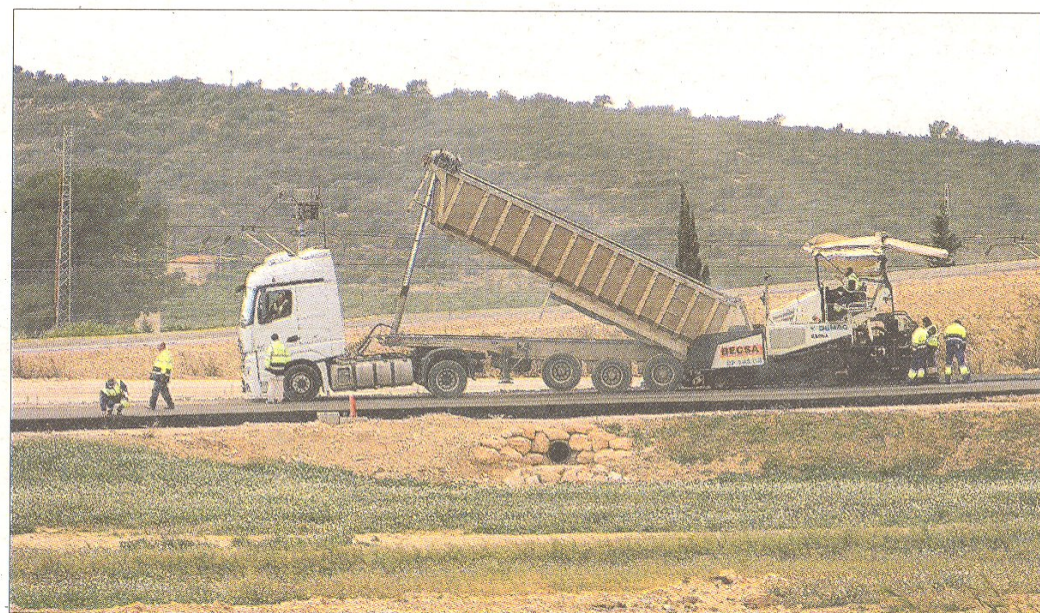
Treballs d'asfaltatge d'un dels accessos a la variant, ahir. FOTO: JOAN REVILLAS
