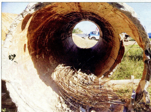
A l'esquerra, imatge de la canonada del CAT que va rebentar el passat 3 de gener a l'Ampolla. A la dreta, el torpede Pipe Diver que s'ha inserit per a inspeccionar l'estat de la xarxa principal del CAT des de Campredó fins a Constantí. / CEDIDA I NÚRIA CARO
