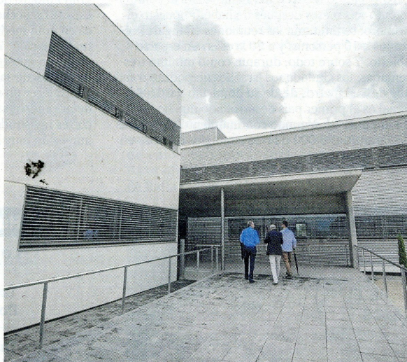
El cribado se llevará a cabo en el CAP de Roquetes. FOTO: JOAN REVILLAS
