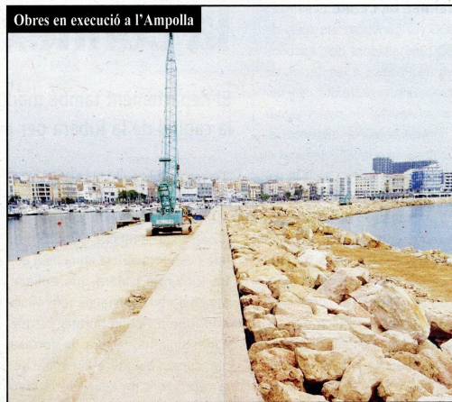
Obres en execució a l'Ampolla
