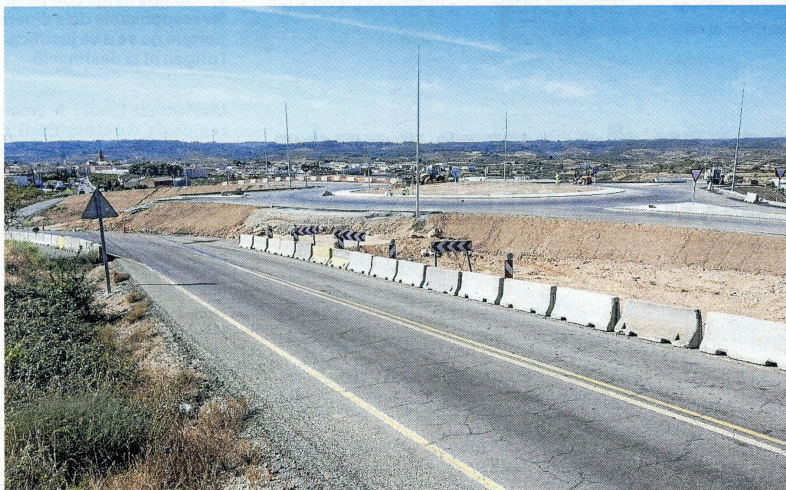
Les obres de la variant de la C-43, ahir a la tarda. FOTO: JOAN REVILLAS
