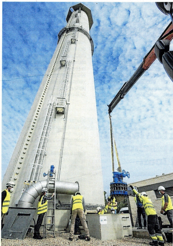
Treballs a les instal·lacions del CAT a l'Ampolla, ahir. FOTO: JOAN REVILLAS
