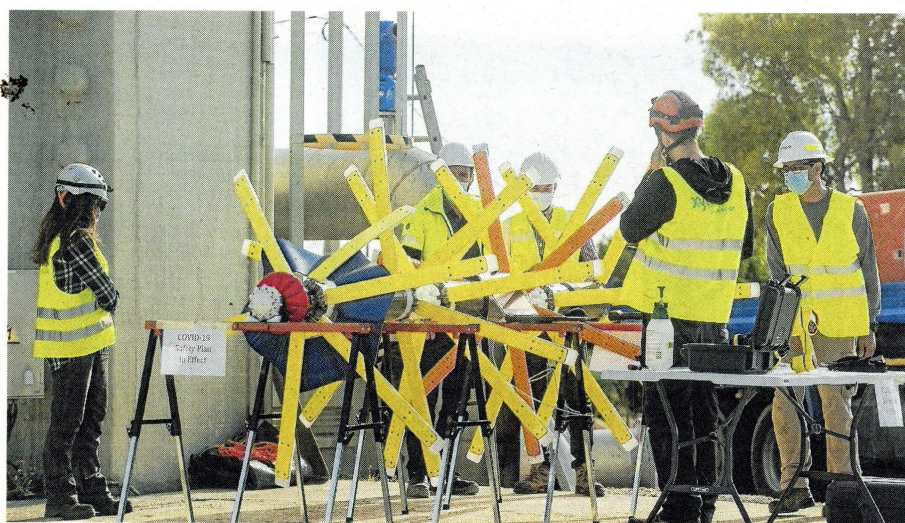
Instal·lant el sistema per revisar tota la canonada. FOTO: JOAN REVILLAS
