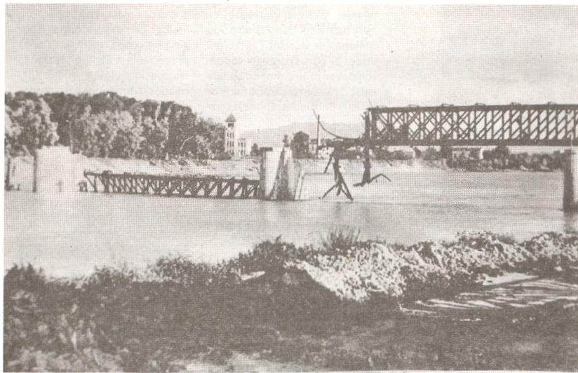
El puente del ferrocarril, sobre el río Ebro, después de haber sido volado en abril de 1938, cuando se estableció el frente de guerra.
