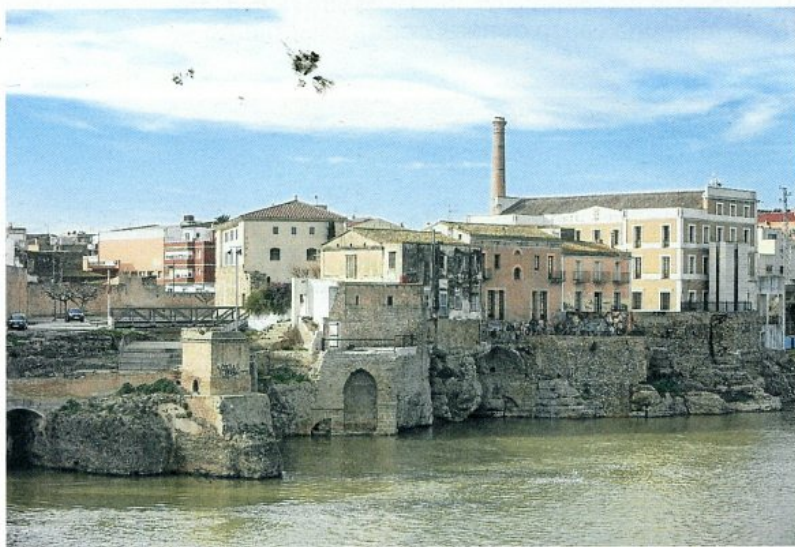
Imatge d'arxiu de la façana fluvial, la rehabilitació de la qual va ser opció guanyadora el 2018. FOTO: J. REVILLAS
